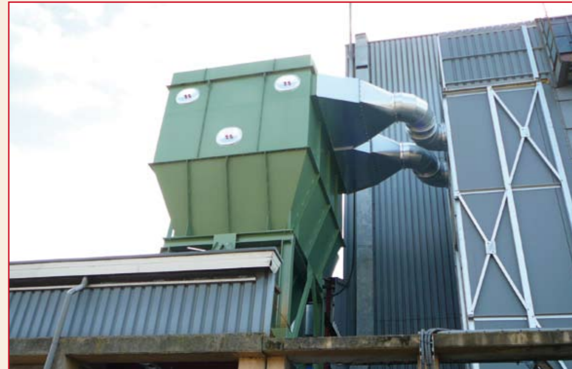
Multicycloon voor biomassa-afscheider in La Mojo, Spanje.
