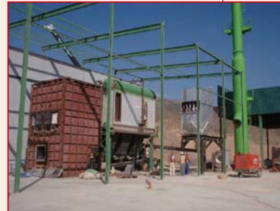
Multicycloon voor biomassa-afscheider in La Mojo, Spanje.
